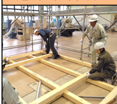
木造住宅の組立て作業体験
