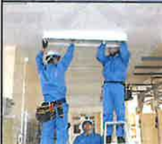
室内照明とスイッチの取り付け、配線体験
