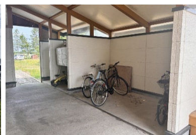
住棟連絡通路と自転車置き場: 錦町団地
