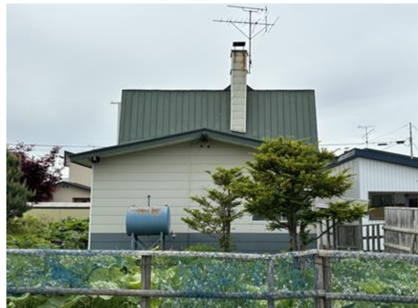
建物背面 (東側)
