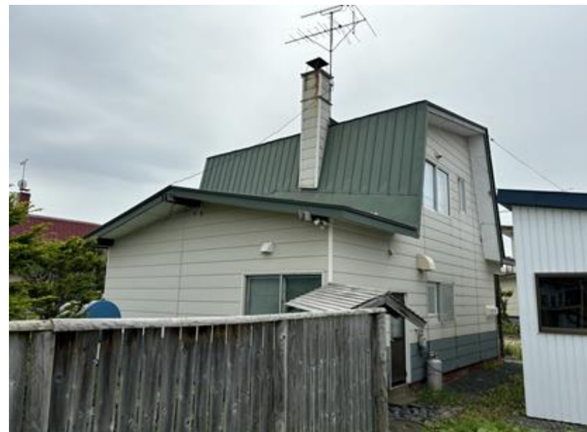
建物外観 (北-東側)
