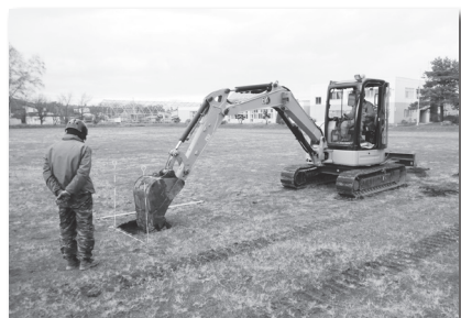
①重機を使って地面を掘り、古い地面を見つける。
