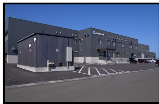
↑今回竣工したホタテ玉冷加工場
