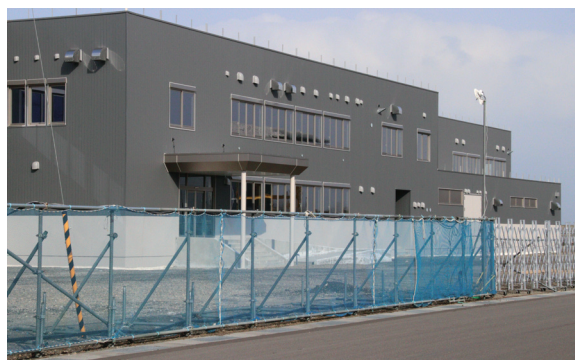
現在建設中の湧別漁協のほたて玉冷加工場
