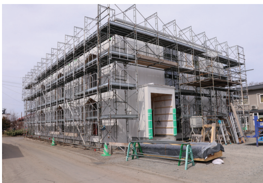
現在建設中の民間会社の社員寮
